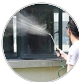
Limpieza de paredes
